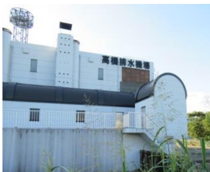
図⑤ 高橋排水機場(朝日町)
